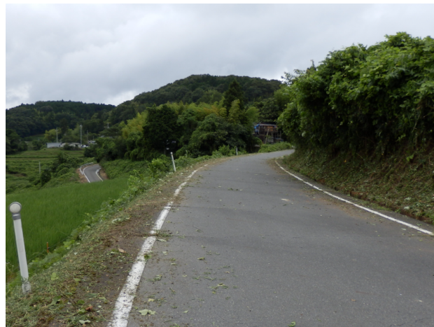
作業後写真①
